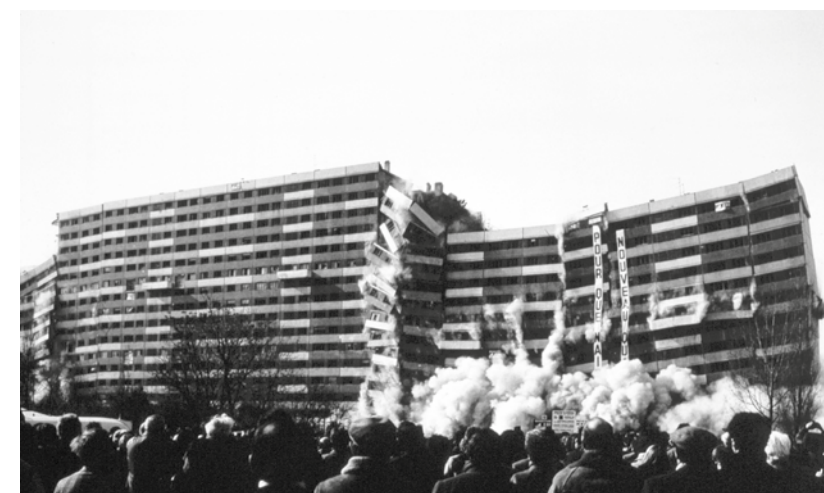
< Gérard Crossay (photographe) Cité des 4000 La Courneuve Démolition de l'immeuble Debussy Photographie 18 février 1986 Médiathèque TERRA, Paris - La Défense Côte : GC40103019 © Gérard Crossay / MEDDE-MLETR
