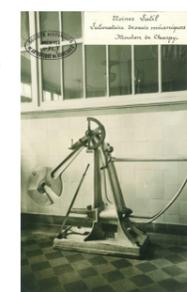
Usine Latil, appareillage du laboratoire d'essai mécanique avec un mouton de Charpy. / © MUS
