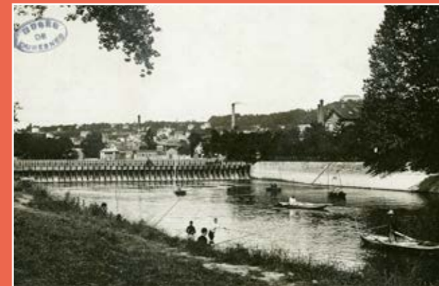
Barrage de Suresnes Inv. 997.00.547
