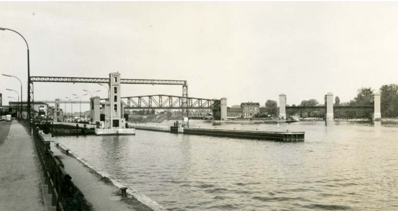
Le barrage-écluses en 1960, inv. 997.00.1298
