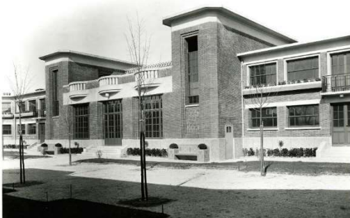
La résidence pour personnes âgées Locarno a bénéficié d'une surélévation.
